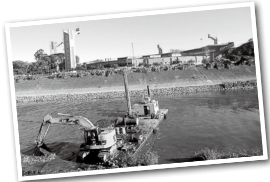
チエテ川の護岸工事
