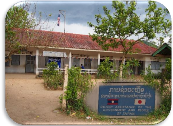
日本の支援で建設された校舎 (ウドムサイ県ラー郡)
