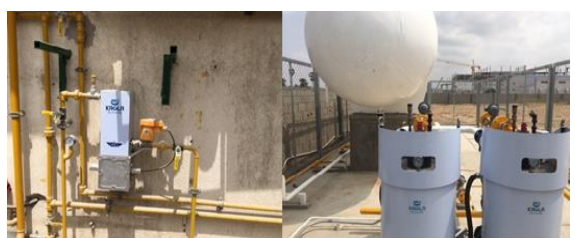
LP ガス蒸発器設備は、クリーンエネルギー(LP ガス)の普及に貢献する
