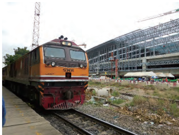
バンスー駅の建設中ターミナルと国鉄車両
