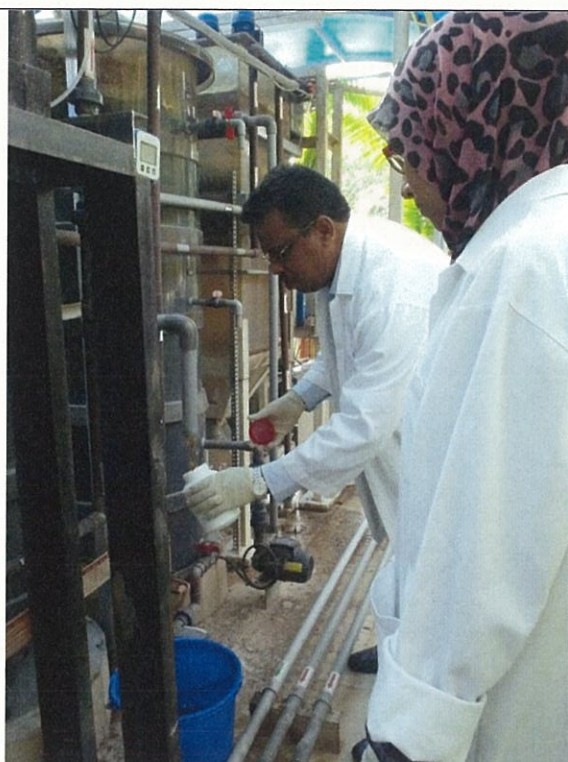
サンプリング作業を促している (活性汚泥戻し管からサンプルが採取されているのが分かる)
