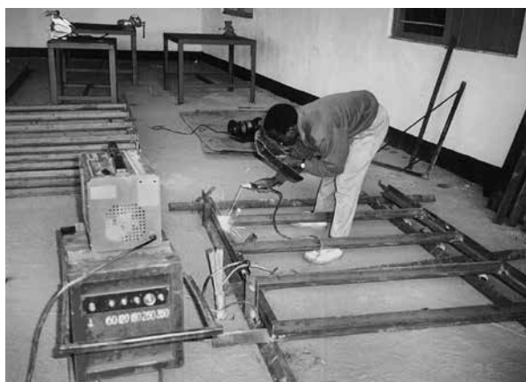
電気溶接の指導と工場の金属棚、作業台の作成
