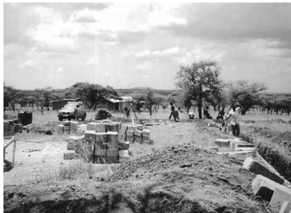
上記工事の基礎工事と建設ブロックの作成
