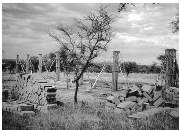
上記工事の金属入りコンクリートの柱の型枠
