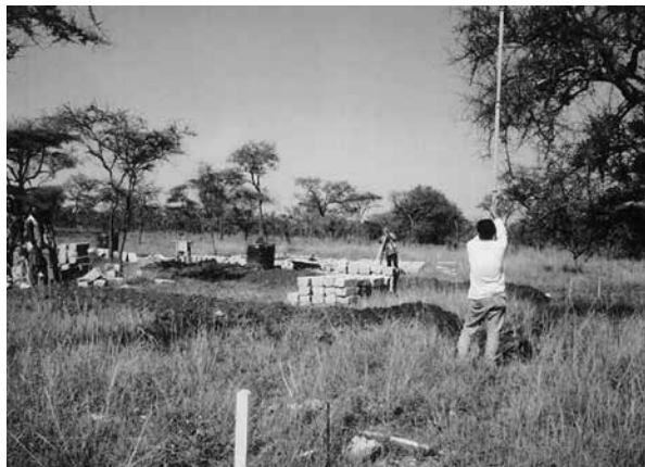
自動車整備工場兼車両駐車場建設の測量作業
