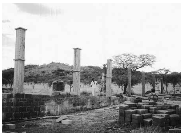
上記工事の金属入りコンクリートの柱に コンクリートの流し込み
