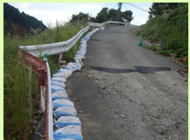
写真2：ガードレールの中がみ、道路の補修跡で2箇所地表地震断層が表れたことがわかる。
