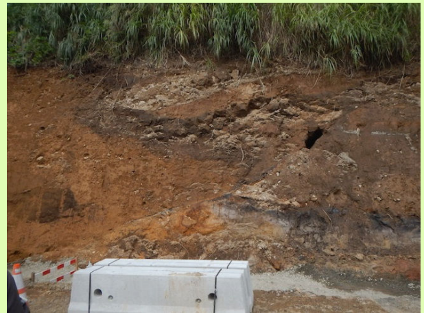
写真1：西原村大切畑に表れた地表地震断層（露頭の高さ約4m）。
