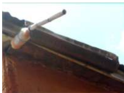
Récupération d'eau de pluie, par des gouttières : bambous comme gouttière, - Utilisation des endroits communs avec toitures en tôles ondulées (exemple : Ecole Primaire, Eglises, Bureaux du Fokontany) pour récupérer l'eau de pluie
