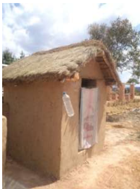
Latrine munie de dispositif pour se nettoyer les mains (système tip-top water) À Andriambilany -Ambatolampy Vakinakaratra
