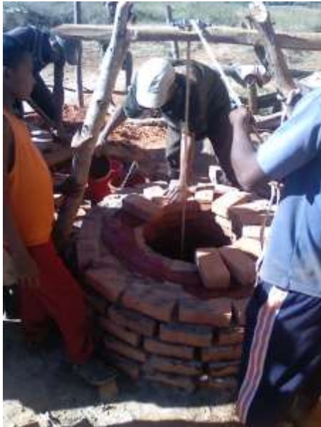
Construction collective de puits, dirigée par un paysan-formateur dans le domaine, utilisant des matériaux locaux
