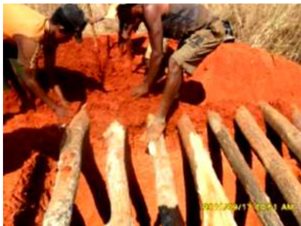
Construction collective de latrines publiques
