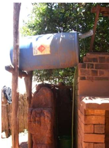
Épuration, par sédimentation, et utilisation de désinfectant chimique
