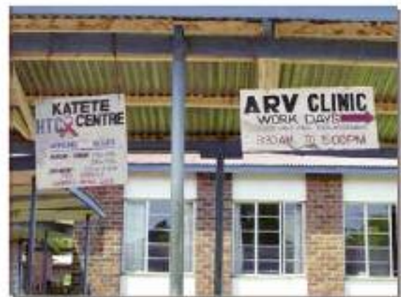
Panneaux suspendus dans les couloirs de l'hôpital
