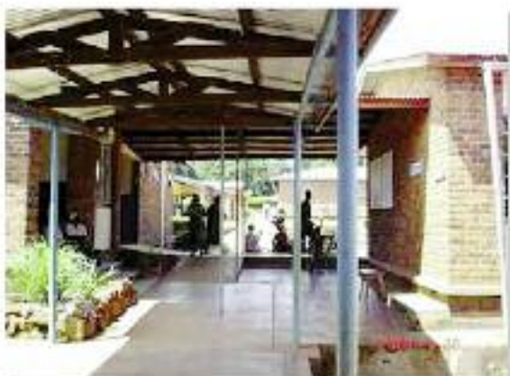
Des rampes se trouvent tout autour de l'enceinte de tout l'hôpital
