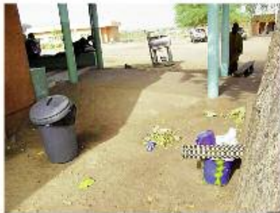
Une rampe reliant le couloir à un autre pavillon
