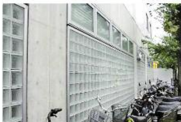
Briques de verre utilisées dans un mur le long de la rue, cachant l'intérieur
