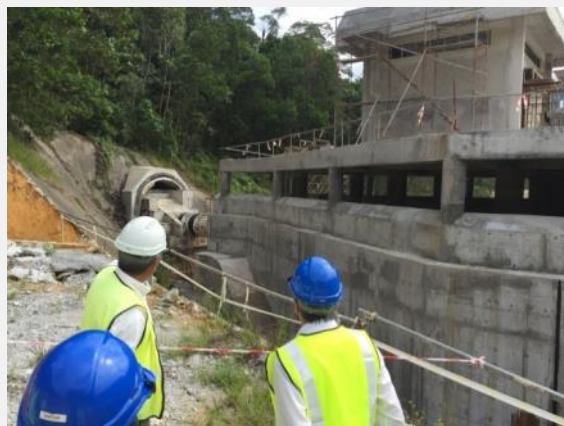
導水トンネルの出口をつなぐ工事
