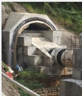
トンネル出口(現在は仮の導水管を接続)
