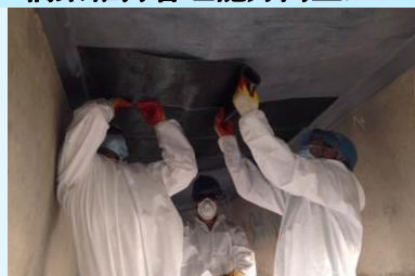
補修パイロット工事で炭素繊維シートを貼付する様子
