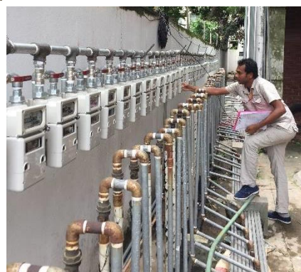
(上)プリペイドガスメーター設備完了の様子 (右)超音波式マイコンガスメーター
