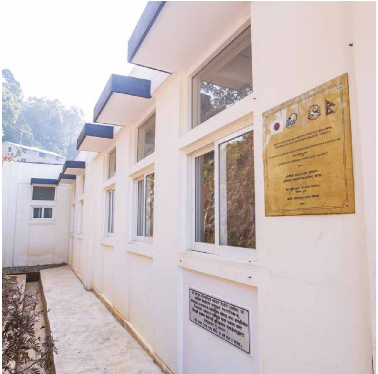
Ampipal Hospital, Palungtar
