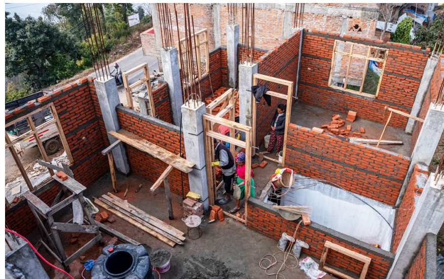
सिन्धुपाल्चोकको साँगाचोकमा निर्माणाधीन घर
