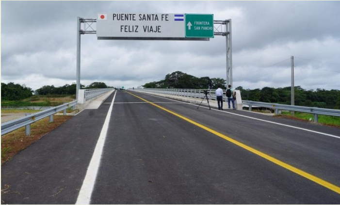
Puente Santa Fe, Ubicado en San Carlos tuvo un costo aproximado de más de U$ 29 millones.
