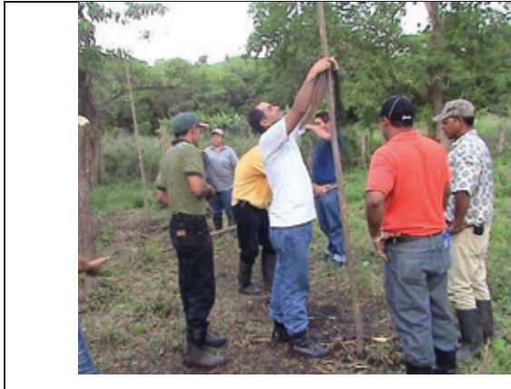
Instalación de Mallas
