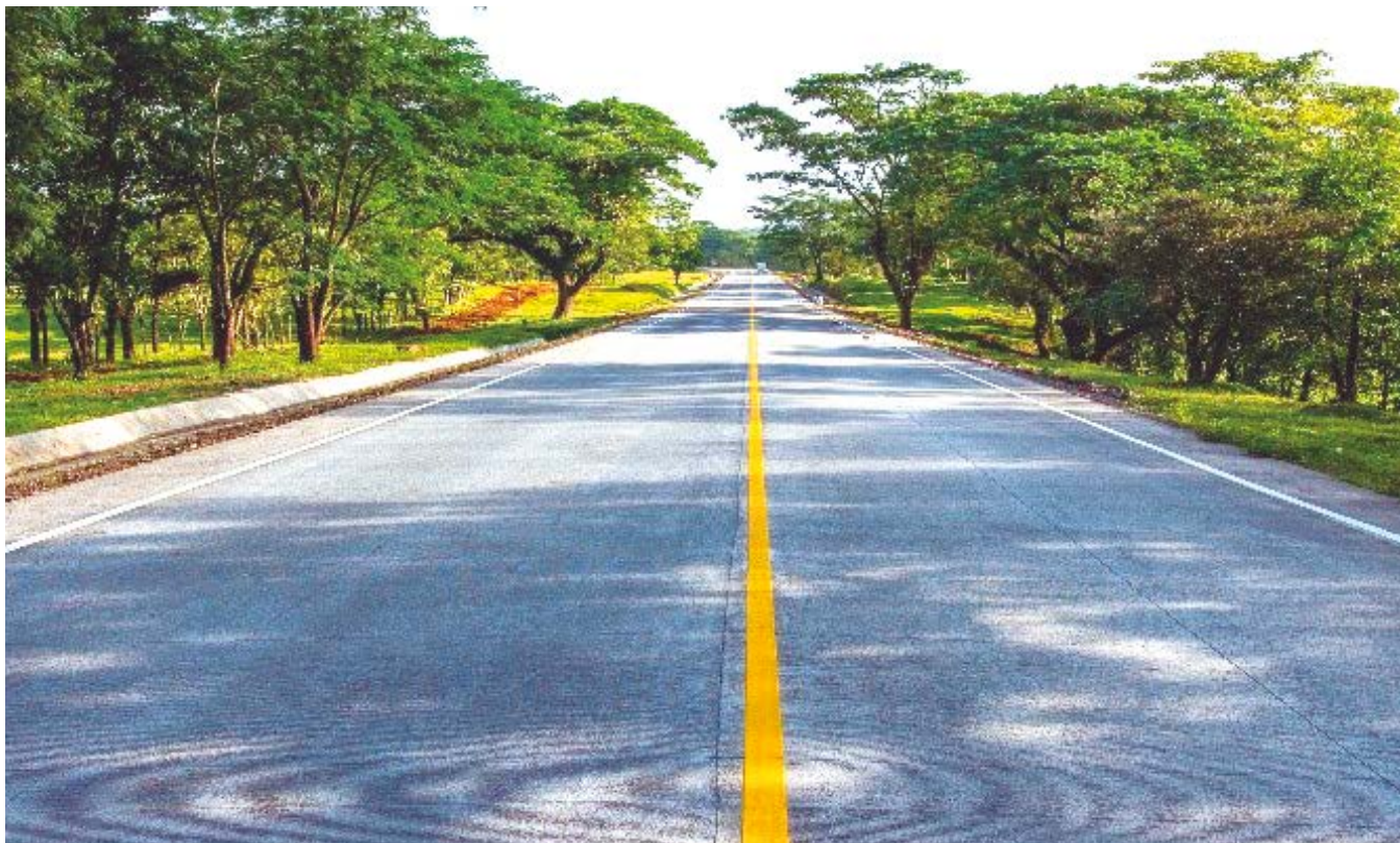
La nueva carretera de concreto hidráulico que une a los municipios de Río Blanco, Mulukukú y Siuna.
