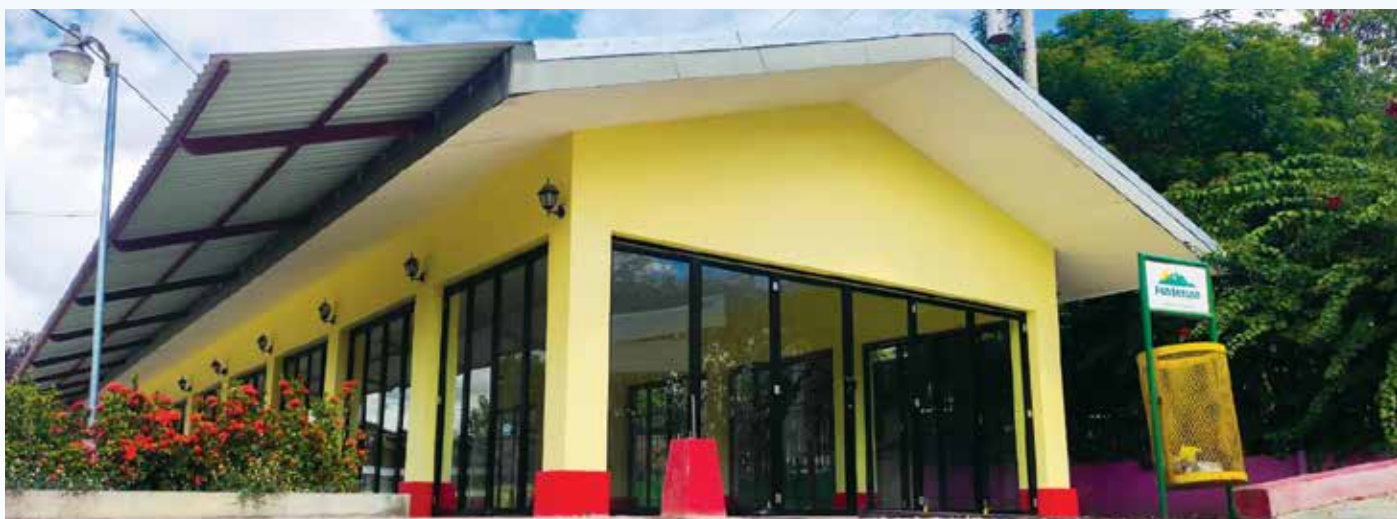
Estación turística de carretera OCOPARD ubicada en el municipio de Ocotal.
