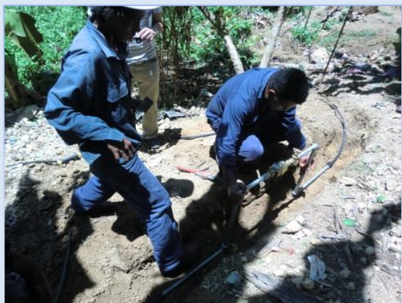
写真-4 水道メータの新規設置作業
