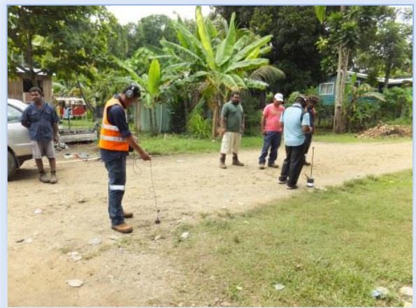
写真-5 漏水探知機器を利用した漏水地点の特定作業
