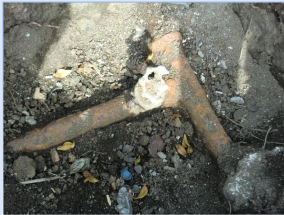
写真-7 敷設後60年以上経過した管路
