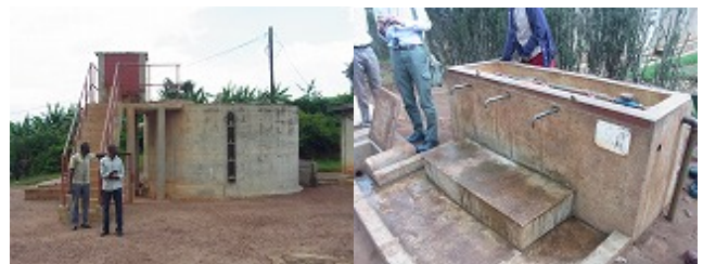
写真1：パイプ給水システムの貯水タンク（左）、共同水栓（右）
