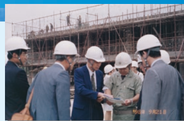
建設当時の様子
