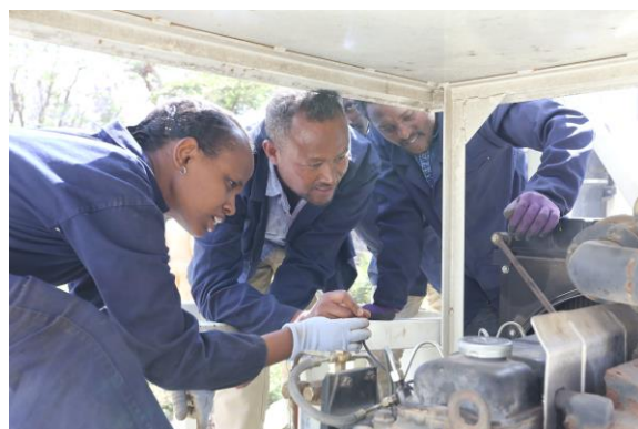
写真 9：実機を確認しながらパイロット研修の準備を行うトレーナーたち（電気機械整備）
