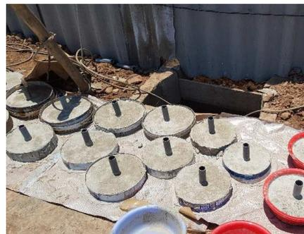
↑パールコンユニットを池底に沈めるコンクリート製の重し。
