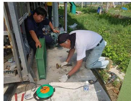
↑パールコンユニット8基を動かす為に新規ブローアの設置を行う様子。
