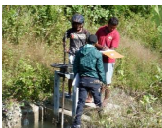
< ゲートキーパーによる水門点検 >
