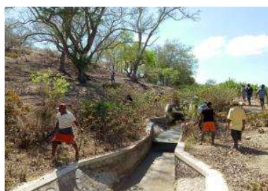
水路清掃の様子
