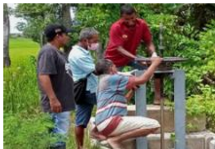
< 水門ゲート維持管理 >
