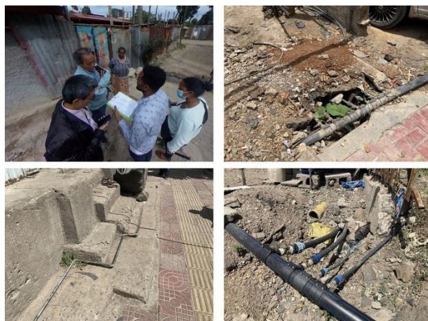
写真 1 露出配管及びスパゲティ管の状況
