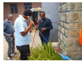
現場での漏水調査
