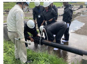
漏水補修研修
