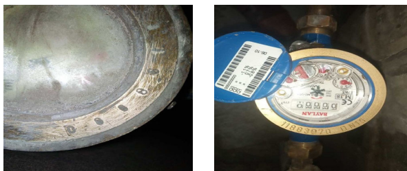
交換前 交換後 写真10 水道メータ交換状況（一例）
