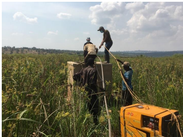
写真：揚水試験を行った井戸
