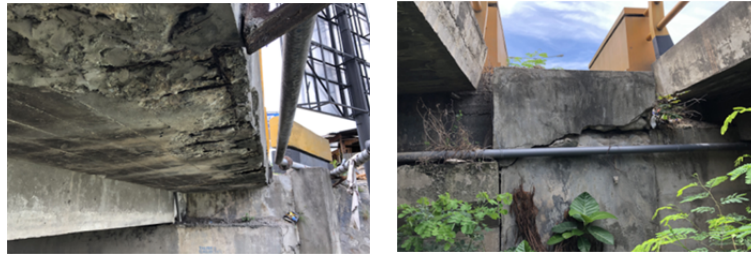
図 2-1-8 ひび割れ、亀裂が生じた橋梁：B5（左）、B9（右）
