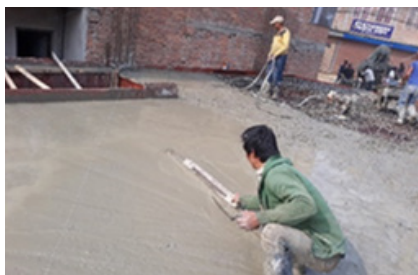
चित्र १५: कंक्रीट राखिसकेपछि ढलान गरिएको खण्डमा सम्याउने कार्य गरिँदै ।
