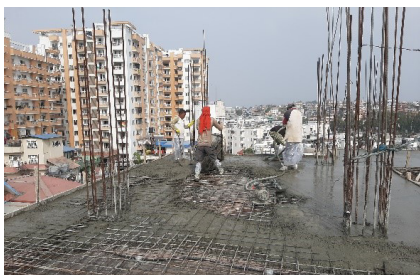
चित्र १५: कंक्रीट राखिसकेपछि ढलान गरिएको खण्डमा सम्याउने कार्य गरिँदै ।
