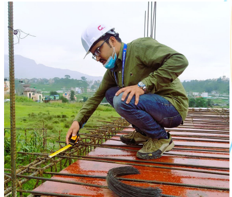
चित्र १: ईन्जिनियरले नक्सा अनुसार भवन निर्माण भए/नभएको जाँच र सुपरिवेक्षण गर्दै
