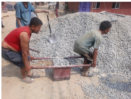
चित्र ७: भवन निर्माण कार्यमा प्रयोग हुने गिट्टी
