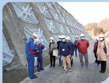
地すべり対策現場
