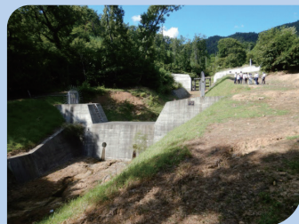
土石流対策現場
