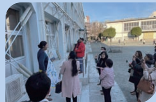
耐震補強済みの学校
