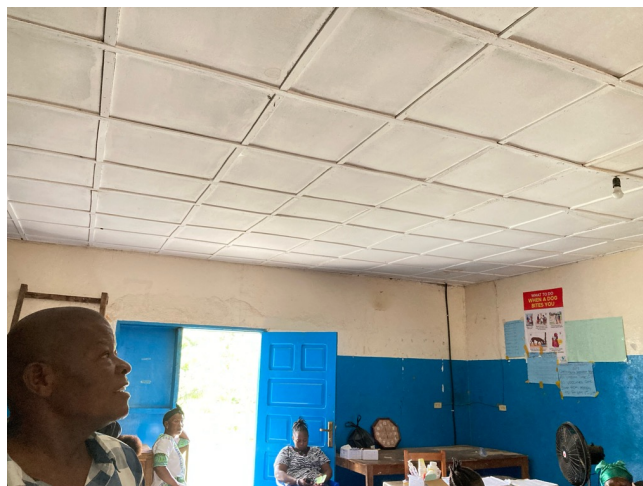
天井を修繕したCareysburg Clinic
