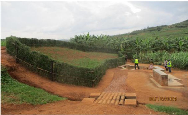
写真 3：湧水水源保護のモデル工事後（カヨンザ郡）
