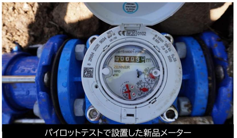
パイロットテストで設置した新品メーター
