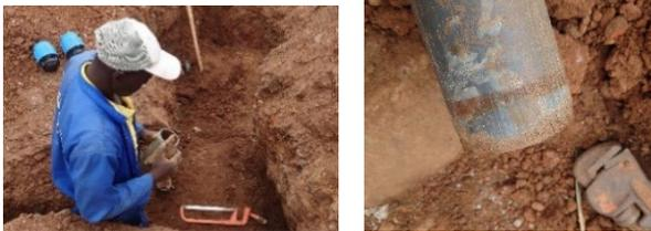
(左) 石を使って PVC 管の面取りをしている様子(右)石で面
