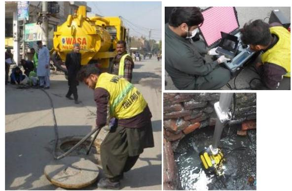
写真 2 下水管の清掃作業の試行
