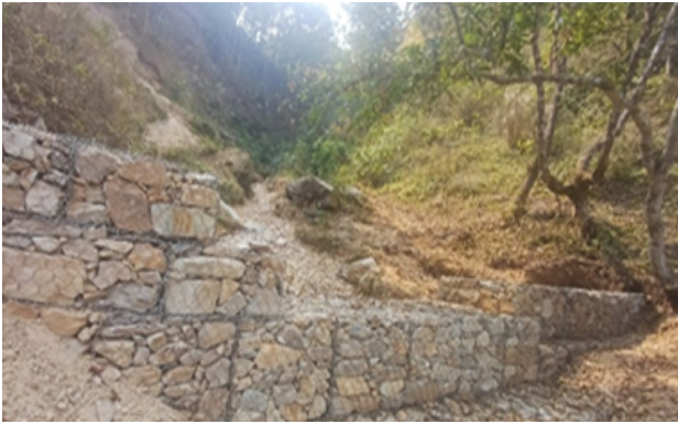
図5：ガリーコントロール (パルバット郡Ek salle CF)
