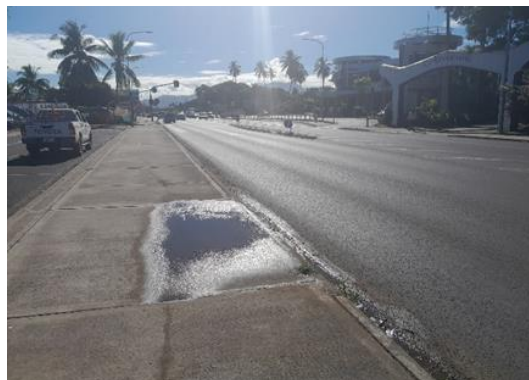
【写真】放置された給水管からの漏水
