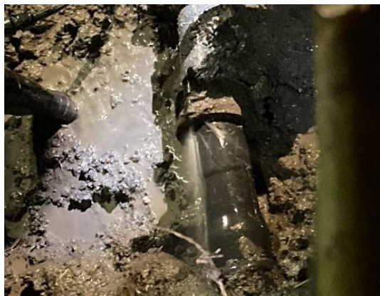
【写真】カップリングのずれ部分より漏水
