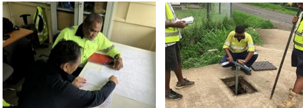
【写真】左:境界バルブ位置の確認作業、右:Sub DMA 内のバルブ機能確認
