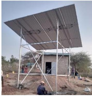
動力給水施設の動力源として太陽光発電を設置
