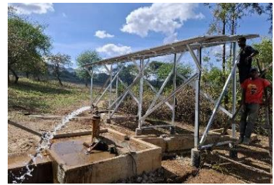
写真2.ハンドポンプの動力化
