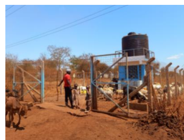
写真1. ハンドポンプを動力給水施設にアップグレード。給水ポイントである公共水栓（写真右）を設置
