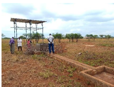
写真1. ハンドポンプを動力給水施設にアップグレード。給水ポイントである公共水栓（写真右）を設置
