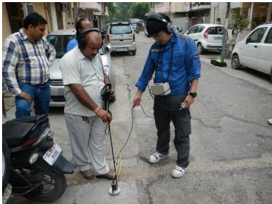
漏水探査ユニットとの現場調査
