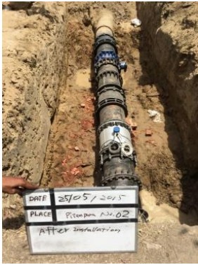
バルブ・流量計据付
