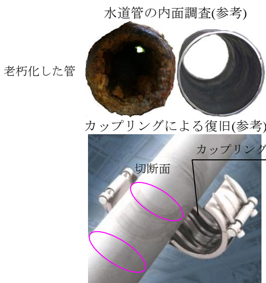
図4 水道管の内面調査及び調査後の復旧方法
