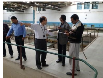
チャンドラワール浄水場の日常点検同行
