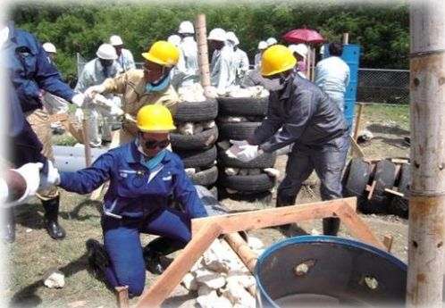
福岡方式の現場実習
