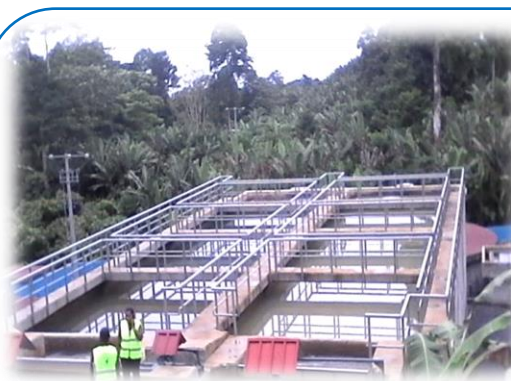
サントメ島の浄水処理施設
