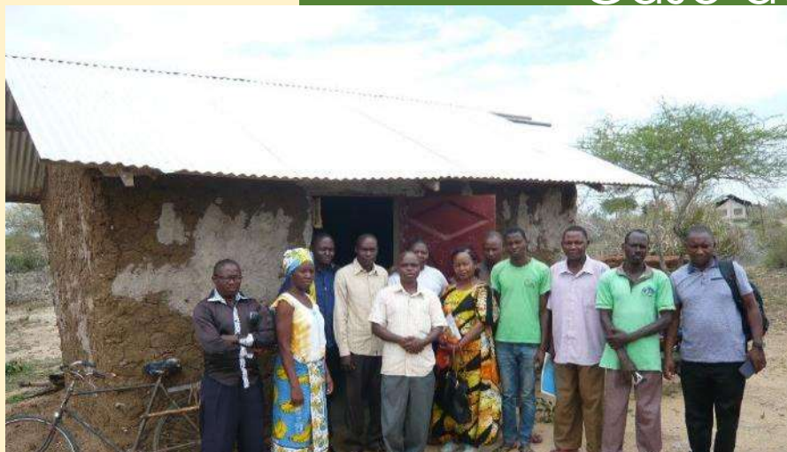
Construcción de nueva oficina para un grupo (en curso)
