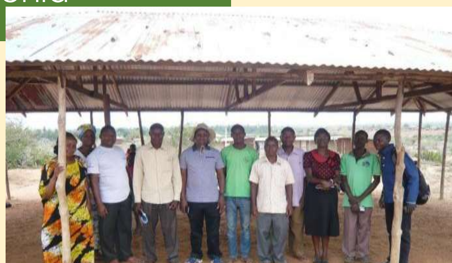
Construcción de nueva oficina para un grupo (bajo construcción)
